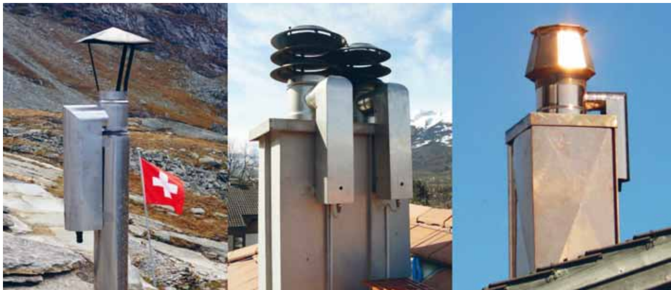
Het Zwitserse Oekotube heeft een fijnstoffilter ontwikkeld dat op de schoorsteen geplaatst kan worden. Onderzocht moet nog worden of dit inderdaad een oplossing is om hout te kunnen stoken zonder of met minimale fijnstofuitstoot.
