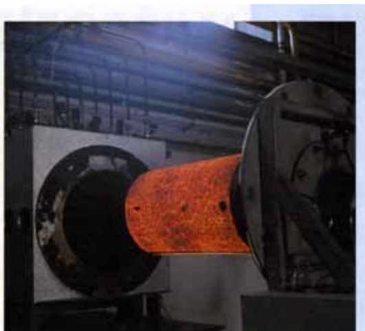
De implementatie van low-NO x -stralijsbranders in ketels is een van de activiteiten van Gasunie op het gebied van een milieuvriendelijke verbrandingstechniek.
