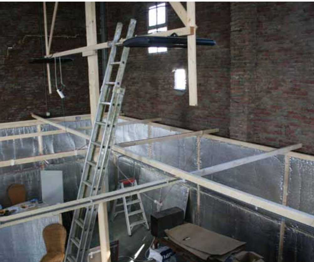
In het gebouw waar iedere isolatie ontbreekt volstaat een opstelling van schermen rond een werkvloer gemaakt van houten constructieplaten. De schermen bestaan uit ramen van dunne latten bespannen met noppenfolie met aluminiumlaag.
