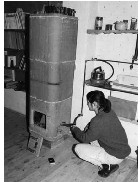
Deze kachel van keramische schoorsteenelementen voorzien van een gasbrander met 'opgesloten gasvlam' werd in 1983 in gebruik genomen. (foto uit ons tijdschrift nr. 30-31 in 1983).
