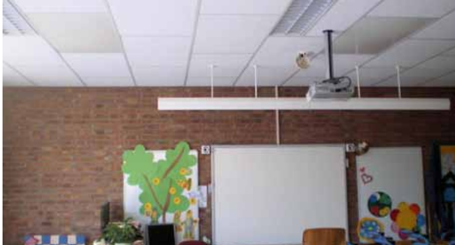
Infraroodpanelen in het systeem-plafond van CNS De Regenboog in Tholen. (foto: An Tech)
