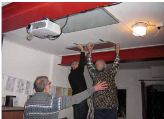
De stralingspanelen worden aan het plafond van de 'bakkerij' bevestigd door v.l.n.r. Rik van Schuur, Matthieu van Bragt en Sjaak Herman. Rik en Sjaak zijn leden van de reparatieclub W.Z.Vl., die regelmatig in de 'bakkerij' bijeenkomt. Matthieu is technisch vrijwilliger van de Stichting.
