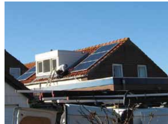
Deze zonnrijke zomer waren ze op tijd op het dak van ons 'filiaal' geïnstalleerd, 6 grote 245 Wattpiek panelen en dat betekende enige honderden kilowatts teruggeleverd!
