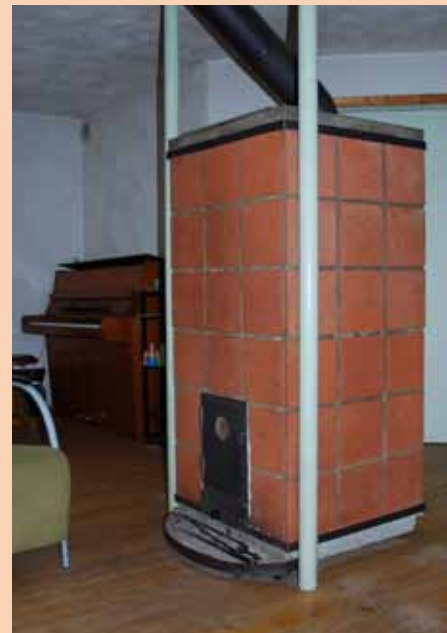
Houtgestookte Fin-oven met ongeglazuurde Kerkdrieltegels.
