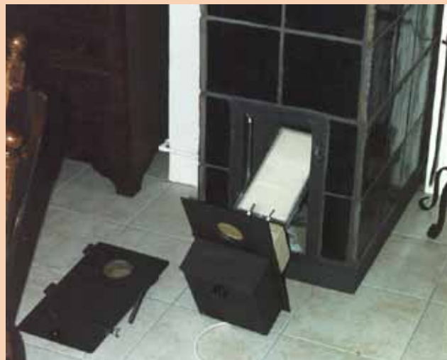
De deurtjes kunnen eenvoudig omgewisseld worden om van houtstoken naar gasstoken over te gaan.
