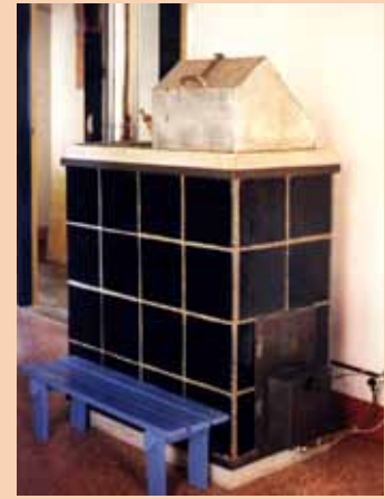
Fornisuitvoering van de standaardtegelkachel. De, door de bouwers zelf geconstrueerde, bakovenkap (aluminium met isolatie) rust boven twee kookplaten waarvan de hete plaat via een gietijzeren cilinder vanuit de stookruimte wordt verhit. Een dergelijke kap biedt isolatie en kan als oven gebruikt worden.
