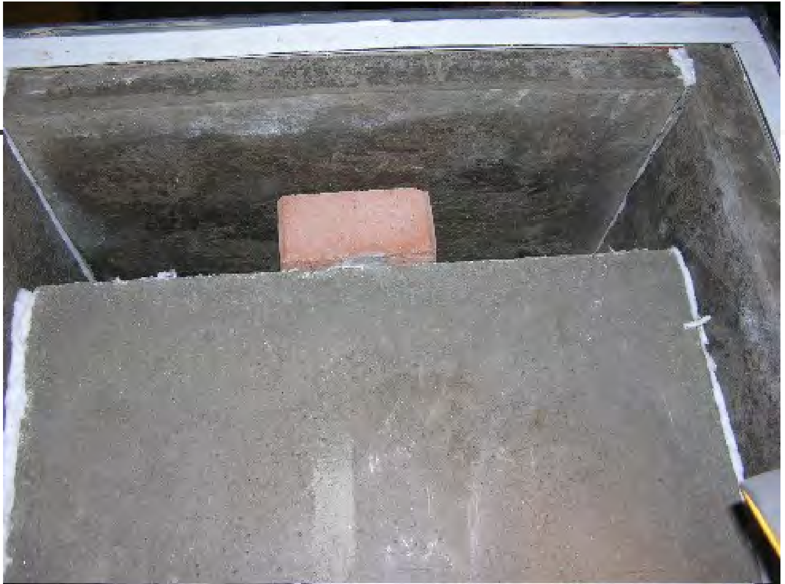
Een laatste kijk op de rookkanalen
